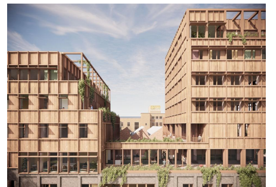
De zuidgevel van het toekomstige gebouw, aan de kant van het toekomstige Parc Béco.
